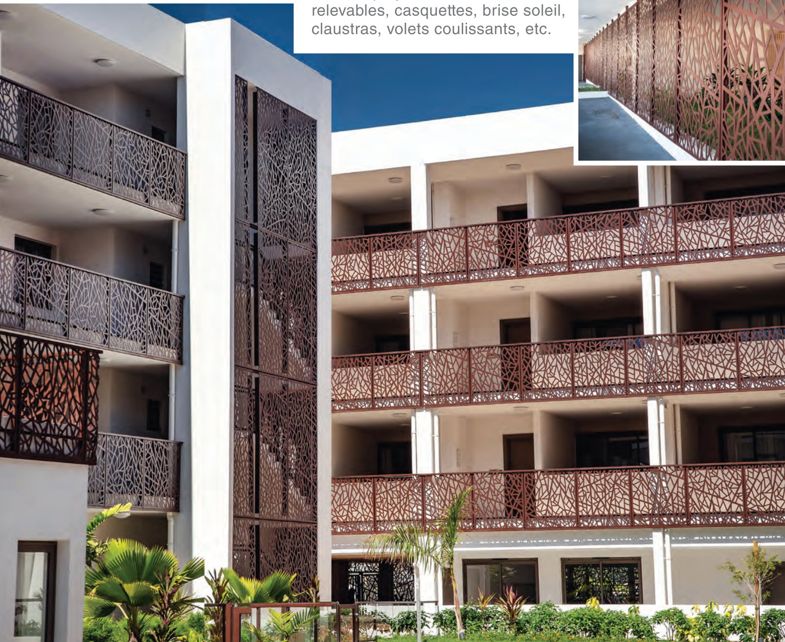
Façade résille et garde corps sur ossature aluminium soudé. Complexe intergénérationnel de Saint Denis.
